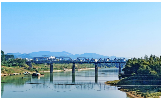
位于雒容镇的雒容铁桥
